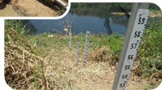
Se continúa también con el reforzamiento estático por todo el eje del dique, para formar una pantalla que prevenga filtraciones como las que produce la hormiga arriera.
